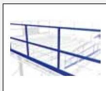
Räcke med sparkplåt
